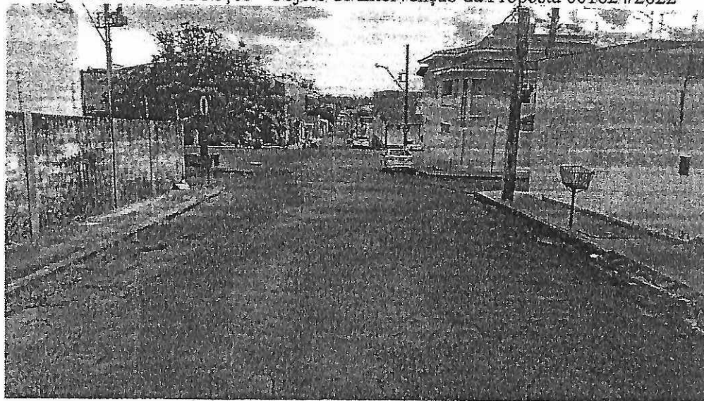
Figura 1 - Rua Dos Poços - Objeto de Intervenção da Proposta 001824/2022
