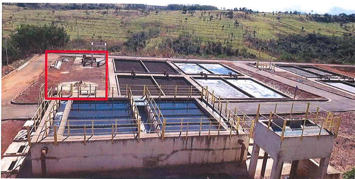
Figura 11. Visita da comissão da CPI a ETE, verificação do local da casa de desinfecção.
