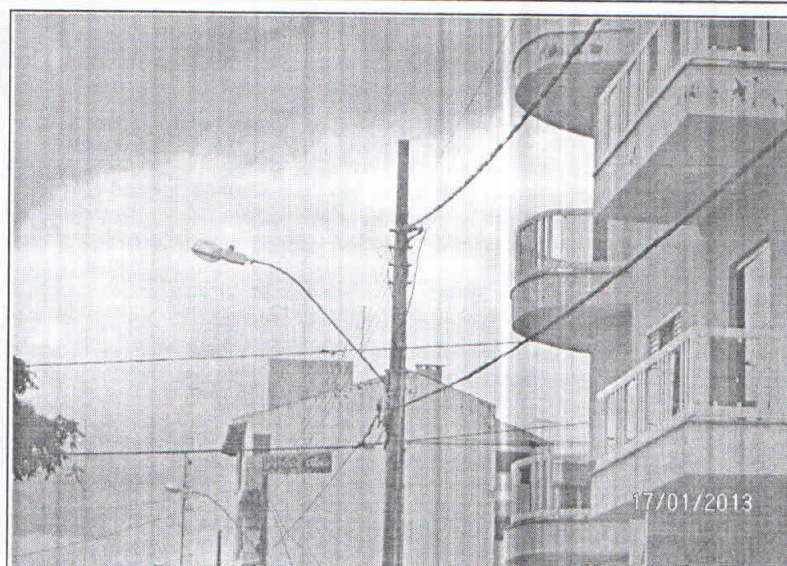
FOTO 08 VISTA DO POSTE PRÓXIMO AO CAND.
